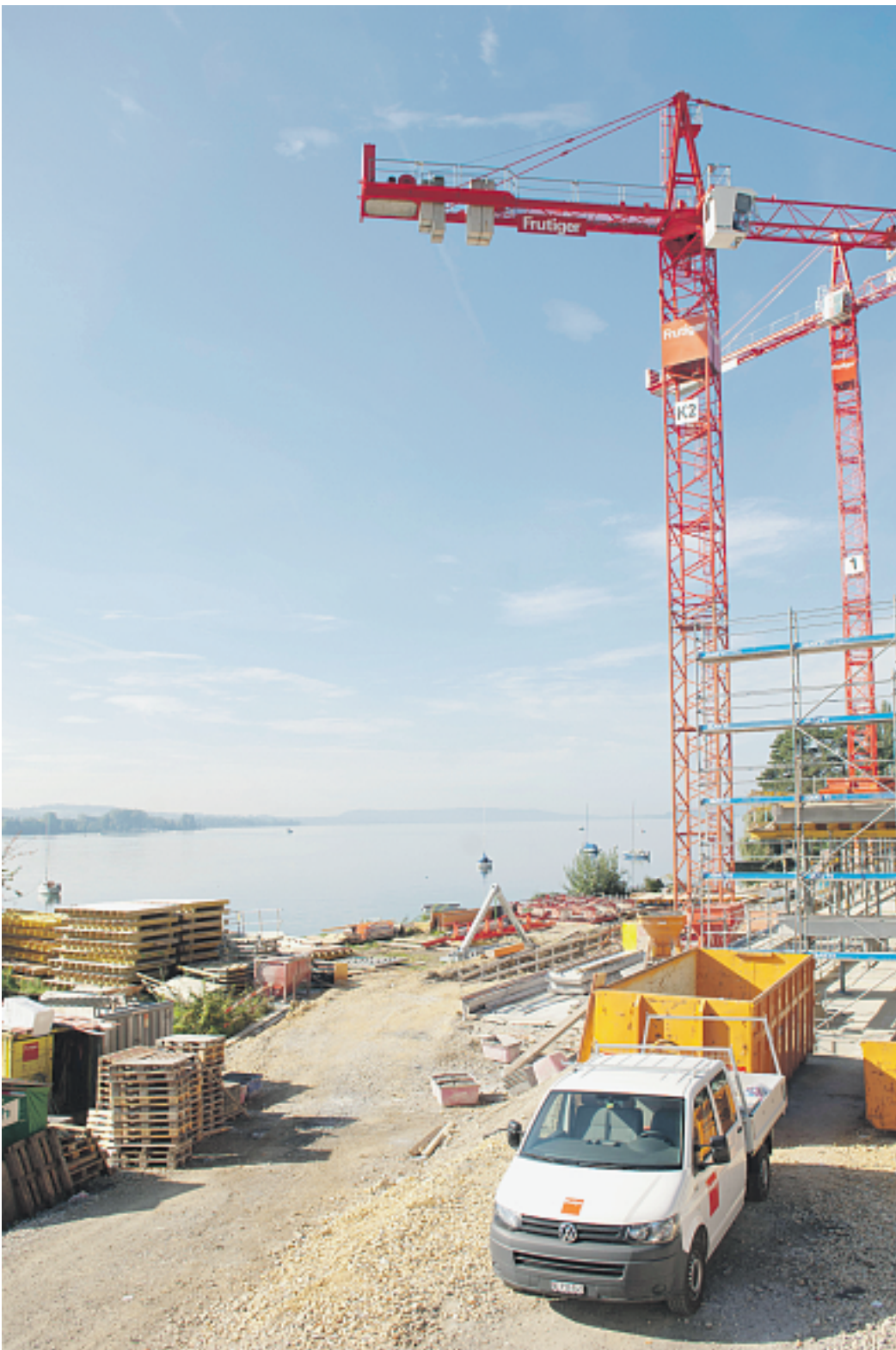
Der Bereich Beau-Rivage ist eine Baustelle. Die Wohnungen, die hier entstehen, sind bald bezugsbereit. Bis das Areal am Ufer fertig gestaltet ist, dauert es noch fast zwei Jahre. Bild: Peter Samuel Jaggi
